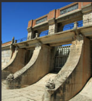
Dique sur de la presa de El Vado
