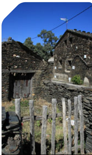
Los materiales principales de construcción se limitan a la pizarra, el barro y la madera
